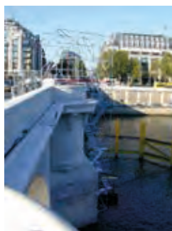
Europe Echafaudage Escalier Pont Neuf à Paris
