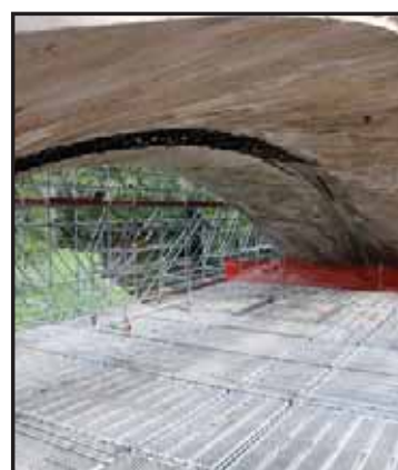
Chantier Pont de Sauldre (41)- ATS © Benjamin Dubuis
