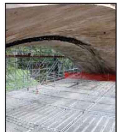
Chantier Pont de Sauldre (41)- ATS © Benjamin Dubuis
