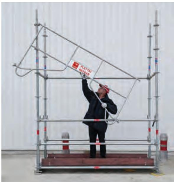
Les garde-corps permanents de sécurité MDS, montés à partir du niveau inférieur déjà protégé.
