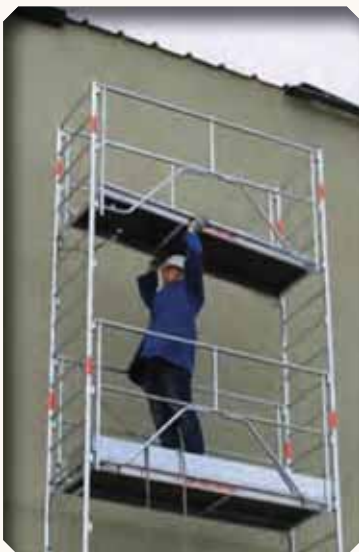
3. Mise en place du plancher Une fois le plancher fixé, il est absolument impossible d'enlever les garde-corps. C'est le principe du montage et démontage en sécurité catégorie 1.
