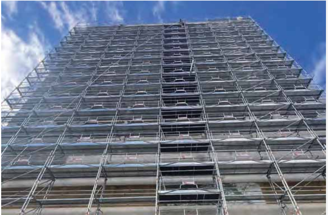
Chantier de façade
