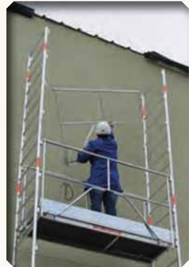
2. Mise en place des garde-corps La fixation des garde-corps est impérative pour passer à l'étape suivante. L'ordre de montage est bien défini.
