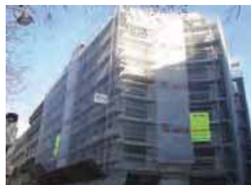
Chantier à Paris (75)
