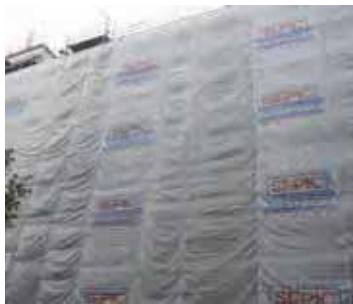
Chantier de la Poste - Rouen (76)
