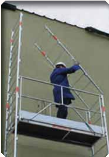
1. Mise en place des échelles
