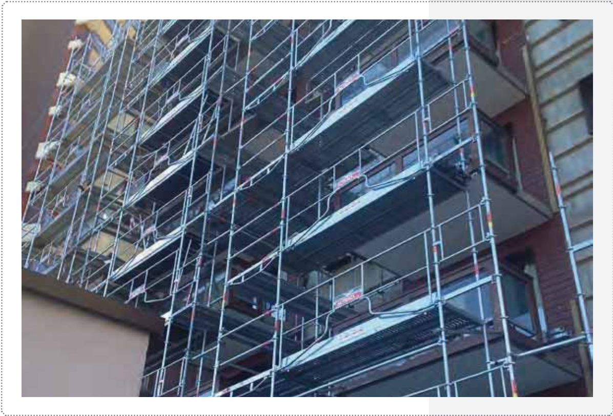
Chantier de façade
