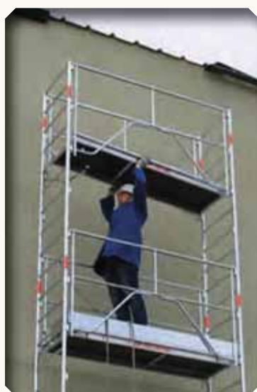
3. Mise en place du plancher Une fois le plancher fixé, il est absolument impossible d'enlever les garde-corps. C'est le principe du montage et démontage en sécurité catégorie 1.
