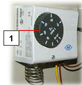
Un thermostat (1) dans le coffret de commande de la plateforme interrompt le mouvement ascendant lorsque les températures sont inférieures à -20 °C.
