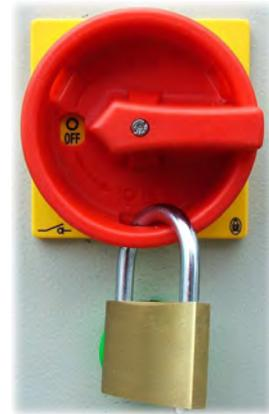
III. 58 Interrupteur principal verrouillé
