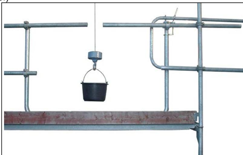
Fig. 6 Sécurisation du point de chargement et de déchargement.
