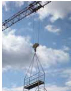
Pour éviter des déformations préjudiciables de la structure, on doit veiller à ce qu'elle soit correctement contreventée dans les 3 plans (2 plans verticaux, 1 plan horizontal) et que les jeux d'assemblages soient compatibles avec l'opération de levage. Tous les éléments doivent être solidaires entre eux (goupilles verrouillables, boulons, pièces de maintien) pour éviter le désassemblage et la chute d'éléments.
