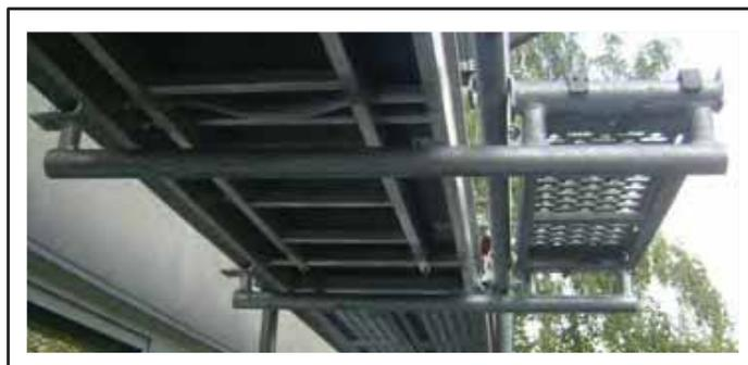
La console permet la pose d'un plancher plus petit que la distance entre poteaux. Le plancher sur les consoles est centré sur la maille porteuse.
