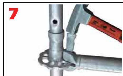
**8-** Revenir au point de départ pour la frappe éventuelle des clavettes et la mise en place de la plinthe.
