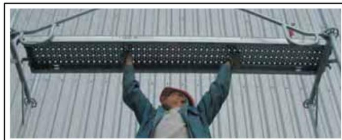
Le montage des planchers s'effectue depuis le niveau inférieur une fois les garde-corps installés. Les poignées assurent une bonne prise en main du plancher.
