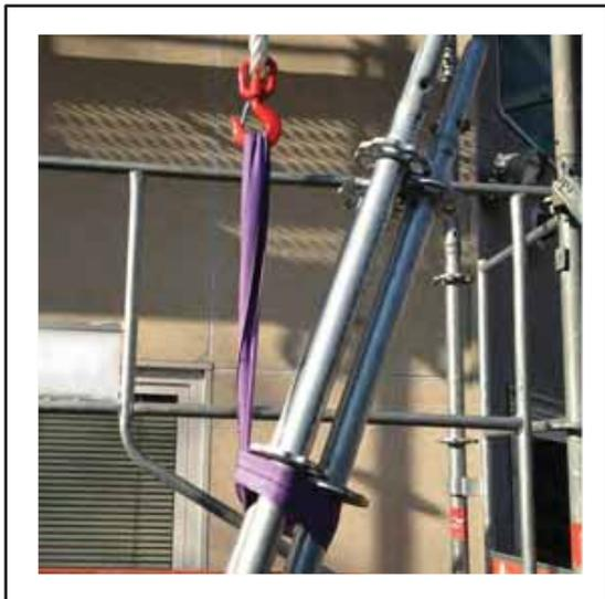
L'accrochage de la sangle sur les éléments de plus d'un mètre de longueur s'effectue au tiers supérieur environ, pour une meilleure saisie du matériel en partie haute de l'échafaudage.
