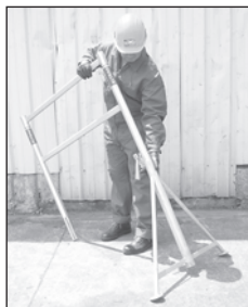
Montage d'un tréteau Dauphiné dédoublé (réf. 1924). Hauteur tréteau : 1.15m
