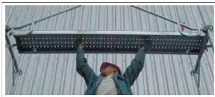
Le montage des planchers s'effectue depuis le niveau inférieur une fois les garde-corps installés. Les poignées assurent une bonne prise en main du plancher.
