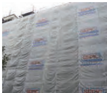
Chantier de la Poste - Rouen (76)
