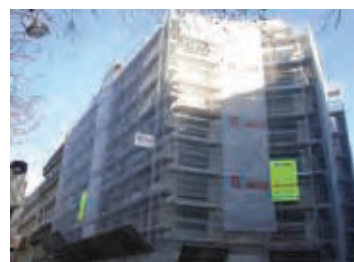
Chantier à Paris (75)
