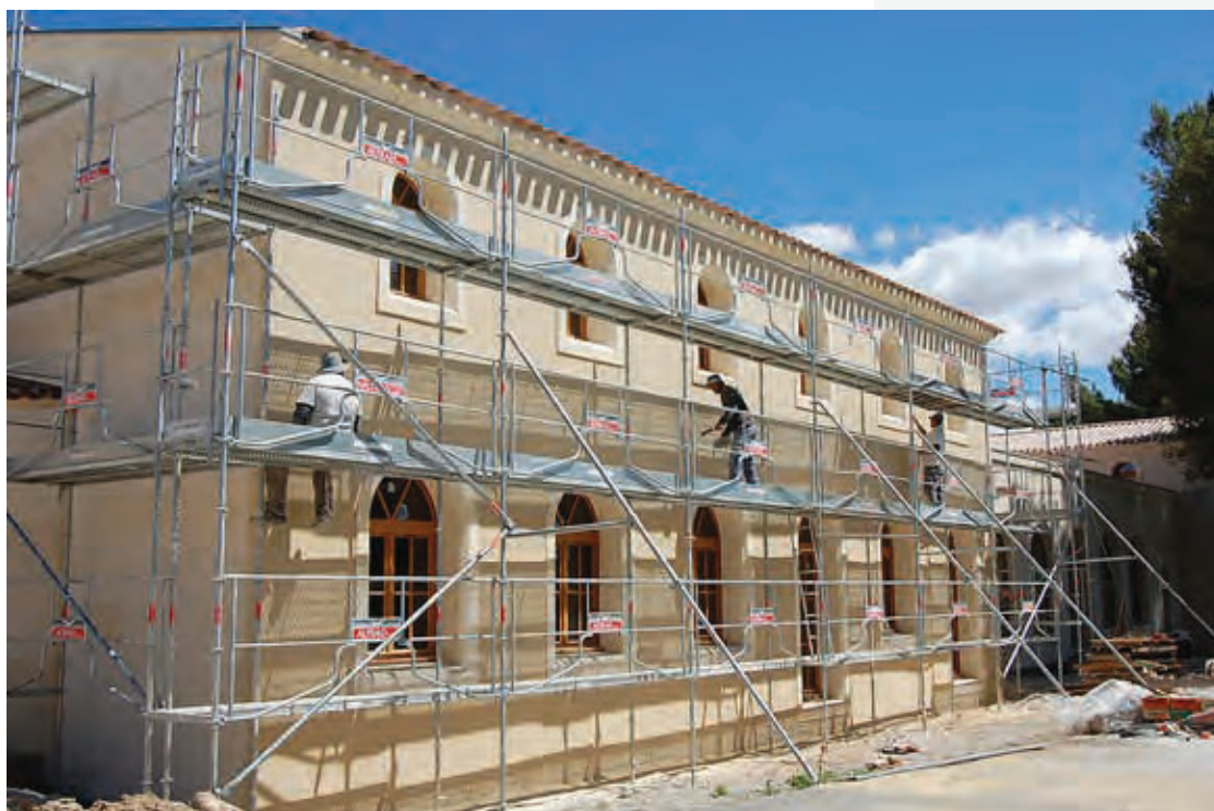
Chantier de façade
