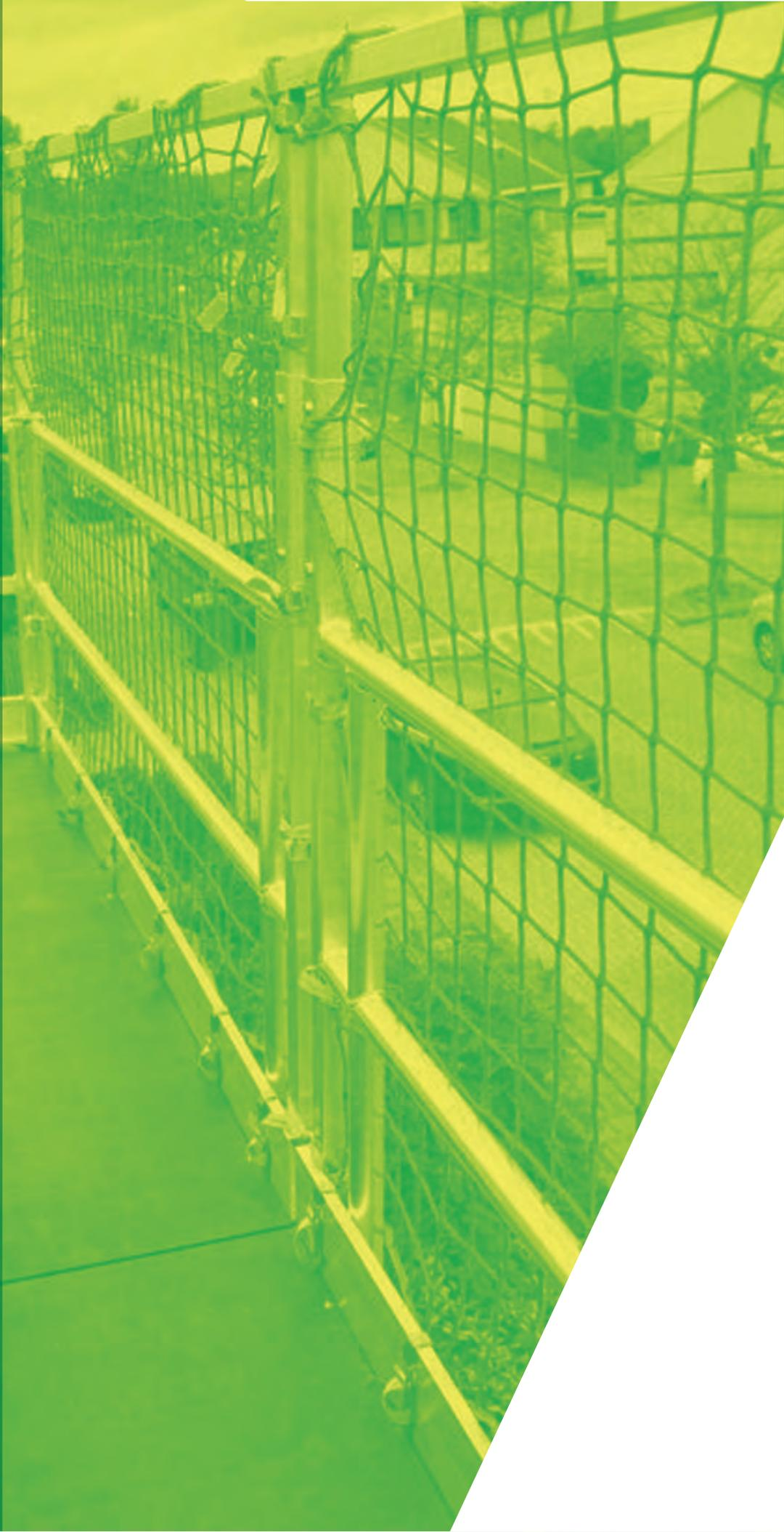
Passerelle triangulaire modulable équipée d'une protection bas de pente, composée de modules alu en forme de V de 2, 3 ou 4 m, de planchers bois, de poutres et garde-corps spécifiques pour accueillir les filets nécessaires à cette application, hauteur plancher 3 à 5m ou 4 à 6m, longueur de 6m00 à 12m00, garantie 5 ans.
