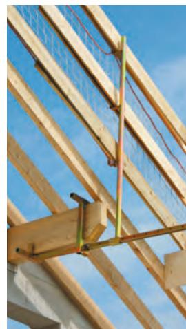
► Ce dispositif permet d'installer rapidement des garde-corps sur les pannes ou poutres bois d'une charpente. Il est conçu pour recevoir des lisses bois répondant aux normes de sécurité et un filet de protection.
