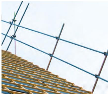
► Si la charpente ne possède pas de poutre, vous pouvez utiliser les protections de rive réglables par traversée de mur (003210).
