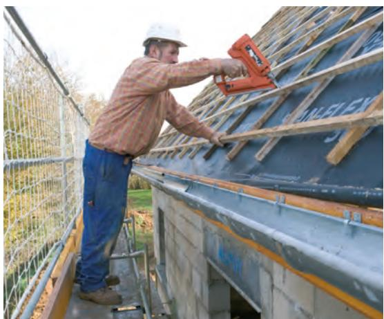
**L'échelle multi-niveaux pour console réglable 1,50m (réf : 003205).** Mise au point avec des professionnels, cette nouvelle échelle répond aux impératifs de sécurité tout en simplifiant l'installation **d'une protection collective en bas de toit doublée d'un plancher de travail à 3 niveaux.**
