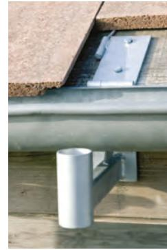
La platine articulée se visse sur les chevrons, son élingue de sécurité s'accroche solidement à la charpente. Une grenouille permet un montage et démontage rapide du câble.
