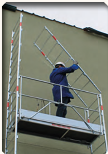
1. Mise en place des échelles
