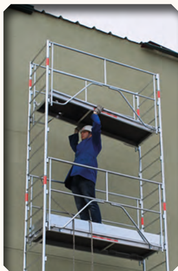
3. Mise en place du plancher
