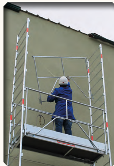
2. Mise en place des garde-corps
