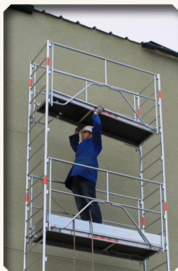
3. Mise en place du plancher
