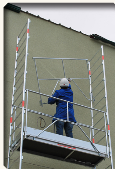
2. Mise en place des garde-corps
