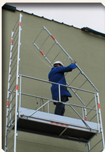
1. Mise en place des échelles
